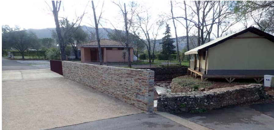
Figure 32 : Mur en rive droite aval du pont en bois du camping (OH12)
