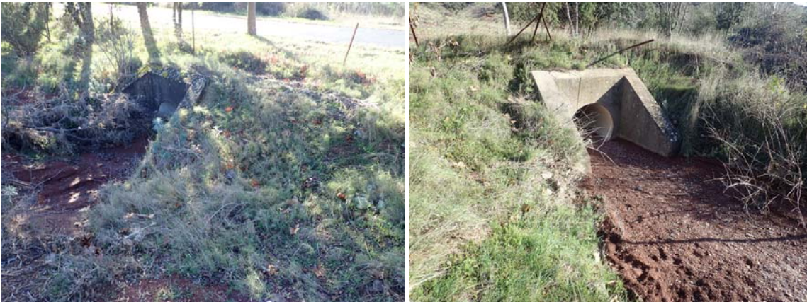
Figure 19 : Vues amont / aval de l'OH04
