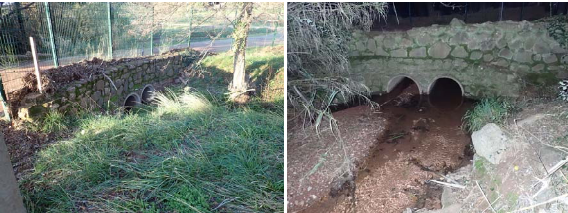
Figure 31 : Vues amont / aval de l'OH16
