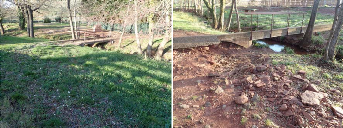
Figure 30 : Vues amont / aval de l'OH13
