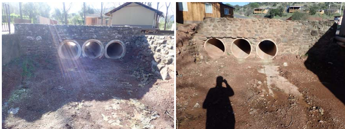
Figure 23 : Vues amont / aval de l'OH11
