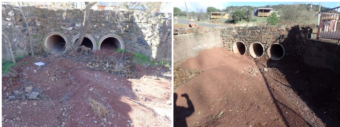
Figure 22 : Vues amont / aval de l'OH08
