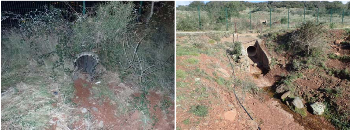
Figure 20 : Vues amont / aval de l'OH10
