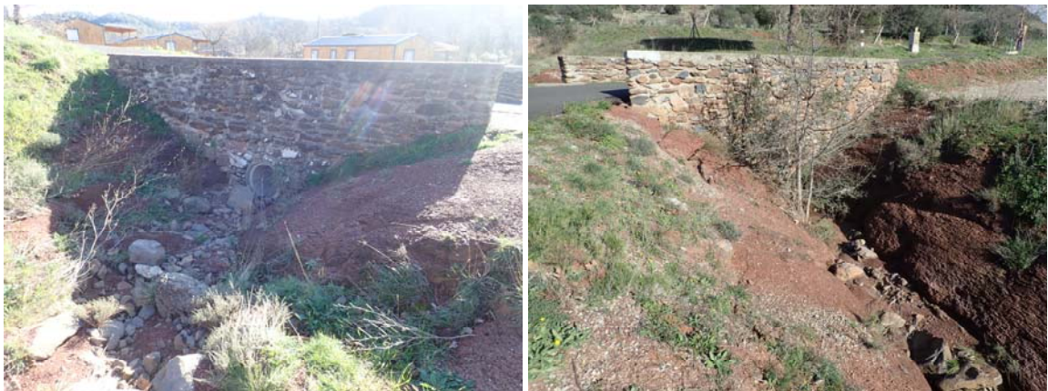
Figure 21 : Vues amont / aval de l'OH09
