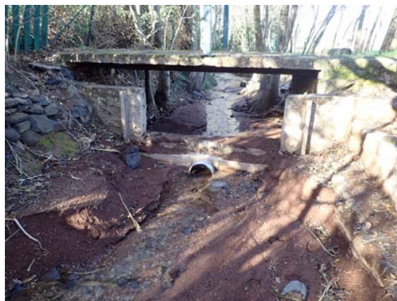
Figure 25 : Vue amont de l'OH05
