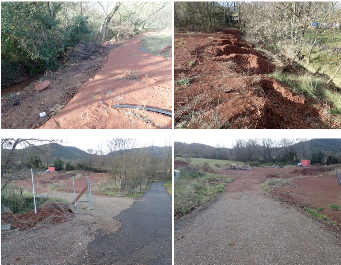
Figure 33 : Remblai en lit majeur du ruisseau de Creyssels et de l'affluent 2
