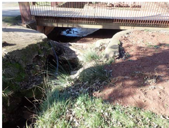
Figure 27 : Vue amont de l'OH27
