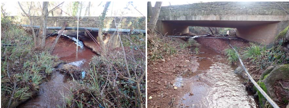
Figure 26 : Vues amont / aval de l'OH15
