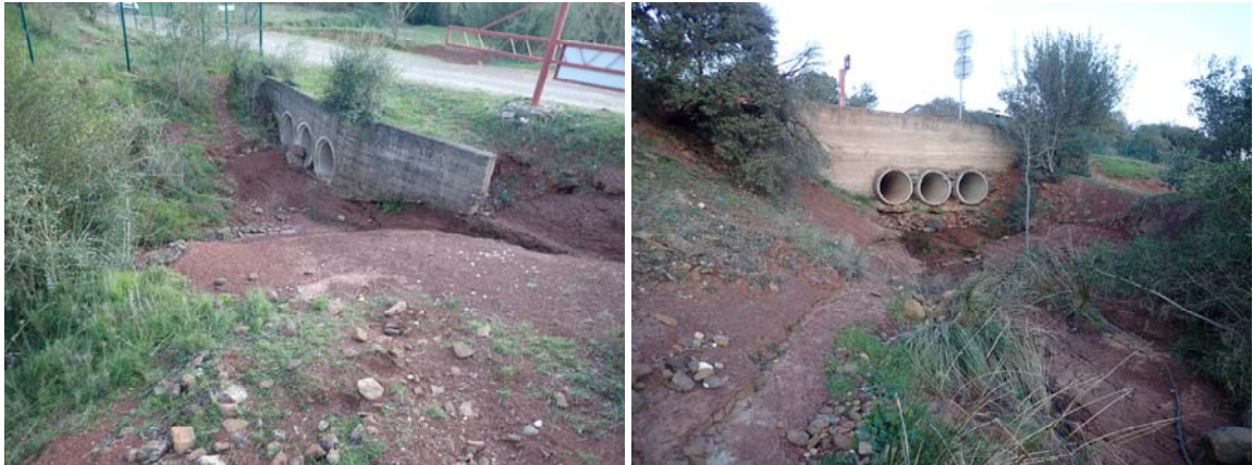
Figure 24 : Vues amont / aval de l'OH15
